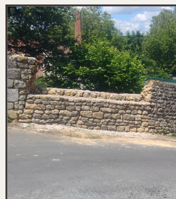
Refection grand mur en enduit chaux
